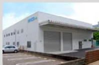
第二生産技術研究棟
