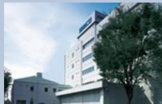
生産技術研究棟
