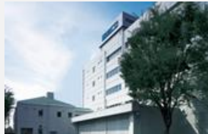
生産技術研究棟
