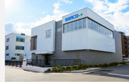
先端技術開発棟
