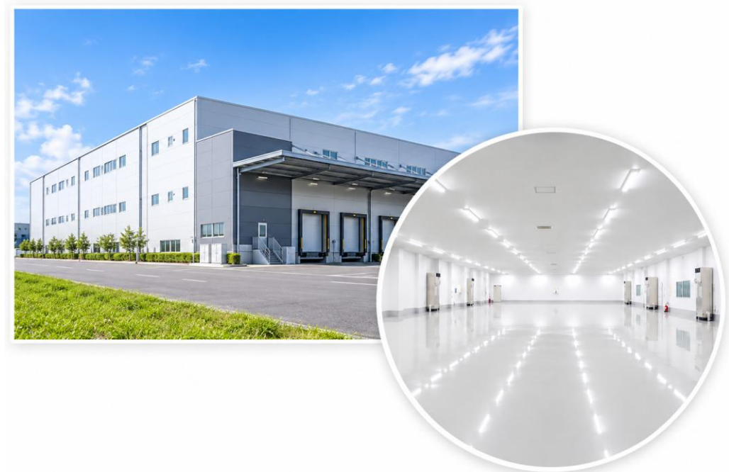
外部協力会社の工場外観・生産スペース
