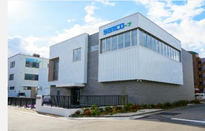
先端技術開発棟
