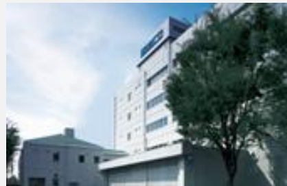
生産技術研究棟
