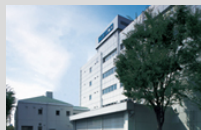
生産技術研究棟
