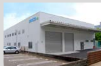
第二生産技術研究棟
