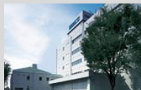
生産技術研究棟
