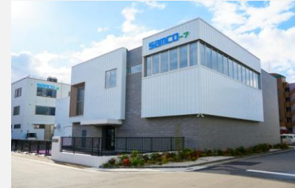
先端技術開発棟
