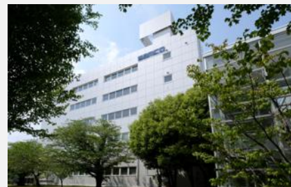
生産技術研究棟
