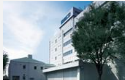
生産技術研究棟
