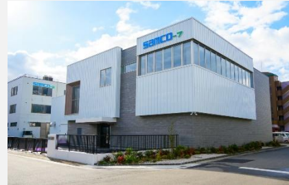
先端技術開発棟
